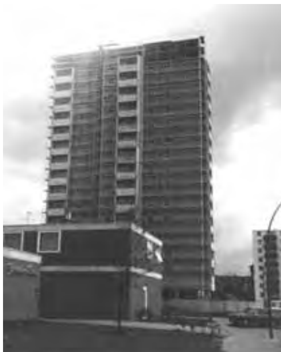
Das vor wenigen Monaten modernisierte Hochhaus am Riesentrapp 6+8 im Rohbau.
